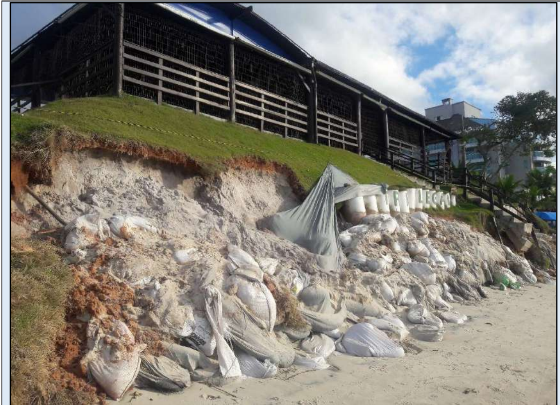
Figura 63. Falésia pronunciada na praia de Canasvieiras, ilha de Santa Catarina, resultado de processo erosivo em maio de 2017.
